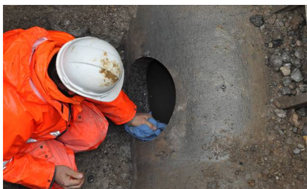
Bild 7: Bohrloch reinigen
