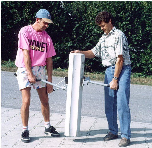
Bild 6: Transport mit Versetzzange
