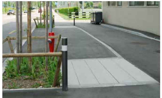
Einbau von Wurzelbrücken seitlich der Baumgrube
