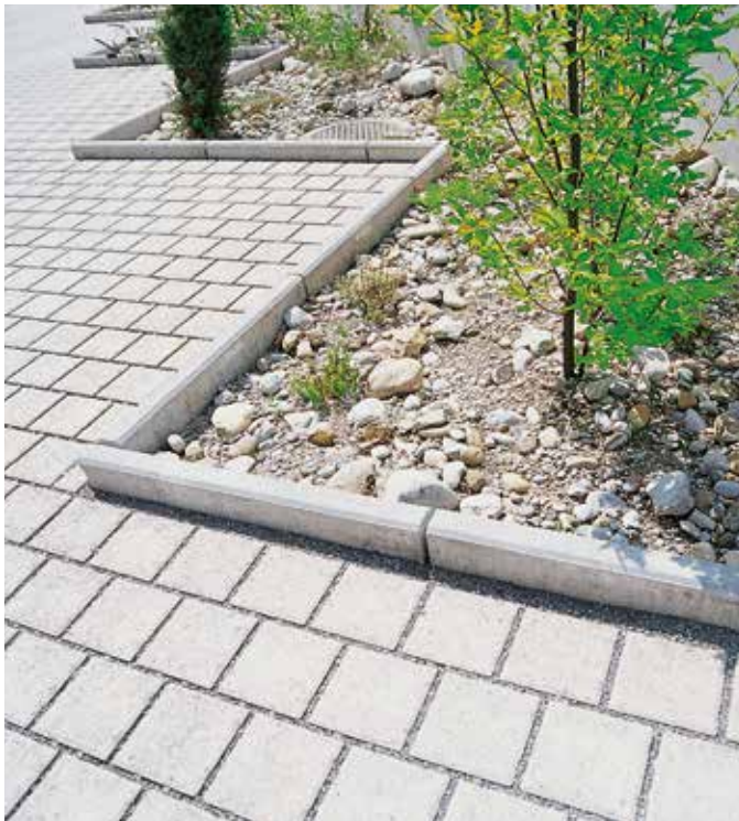
Randabschluss mit offenen Fugen
