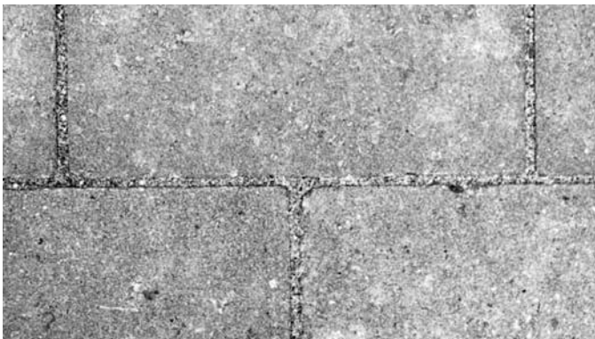
Wirksame Pflasterdecke durch funktionsfähige Fugen
