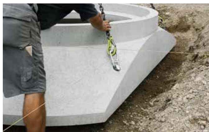
Versetzen des Basiselementes
