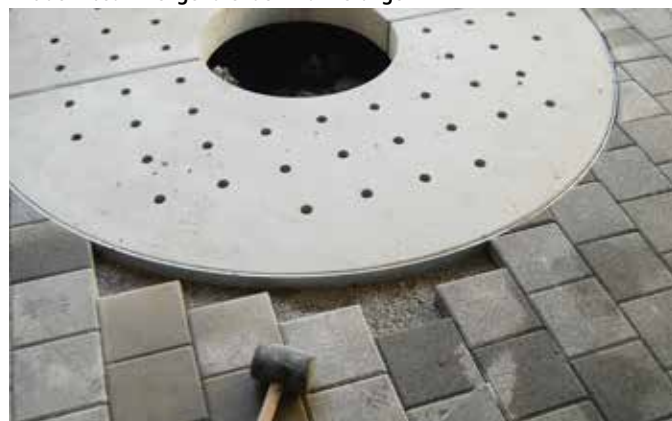
Versetzte TREETUB Betonabdeckung 2-teilig
