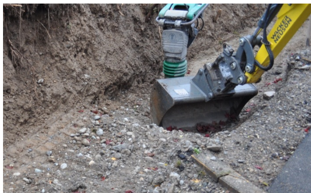
Bild 20: Erstellen der Sauberkeitsschicht
