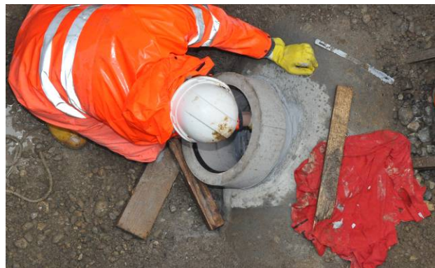
Bild 12: Innenkante von Hand modellieren und Reste entfernen
