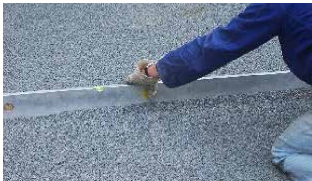
Nivellement du lit de pose
