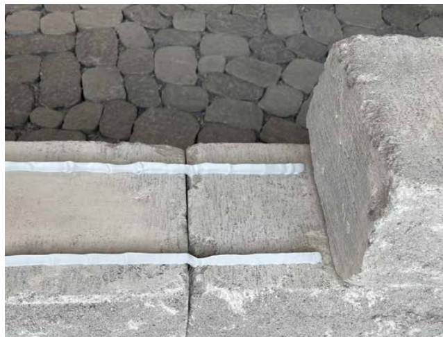
Illustration 1 : Encollage d'une rangée
