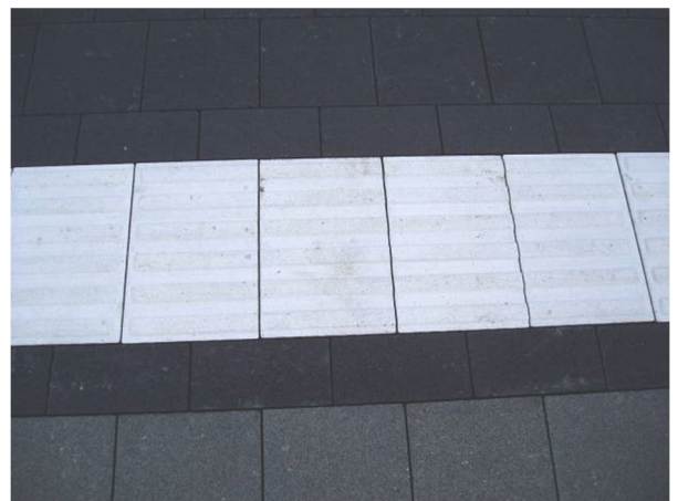
Bild 25: Optimale Fugenbreite
