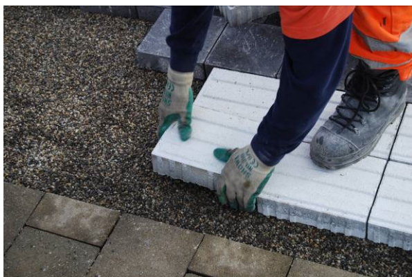
Bild 27: Verlegen von CARENA® Sicherheitsliniensteine H = 6 cm
