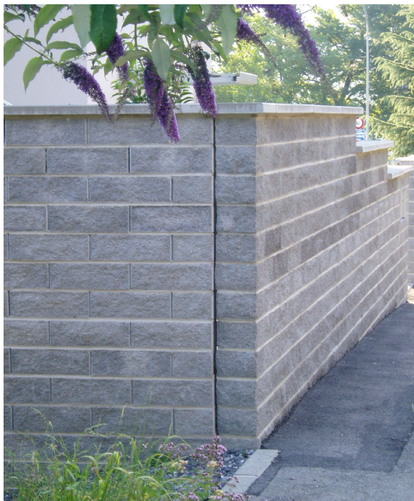
Bild 15: Dilatationsfuge (Produktneutral)
