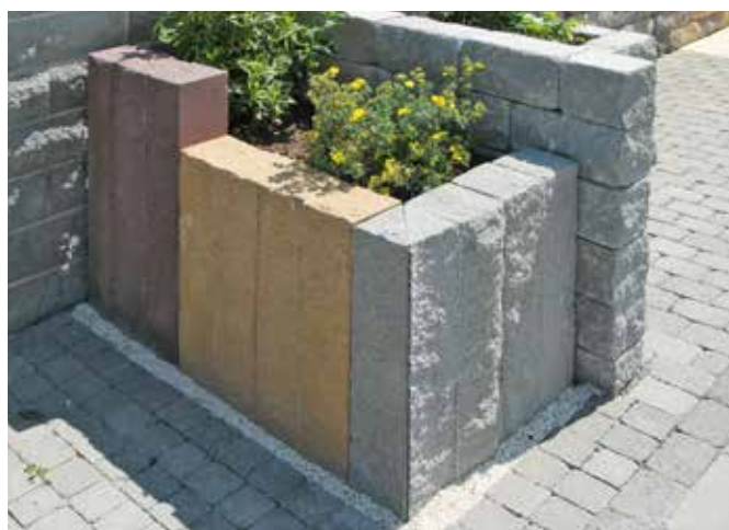
Eckelemente entstehen durch Gehrungsschnitte aus Standardelementen.
