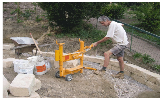
Bild 35: Arbeiten mit Steinspalter
