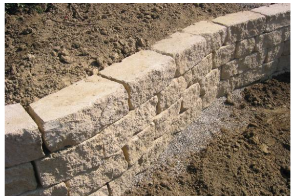
Bild 28: Kurvenbildung mit geraden Steinen
