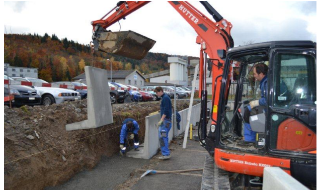
Bild 35: Versetzen der Winkelplatten
