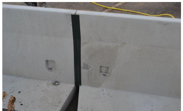
Bild 40: Abdichten der Fugen
