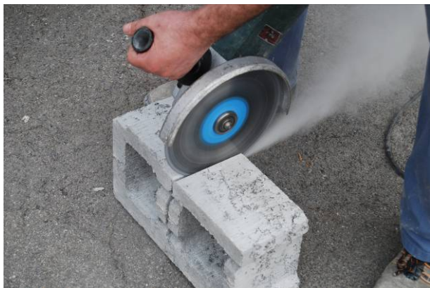
Bild 52: Trennen der Spaltsteine mit Winkelschleifer
