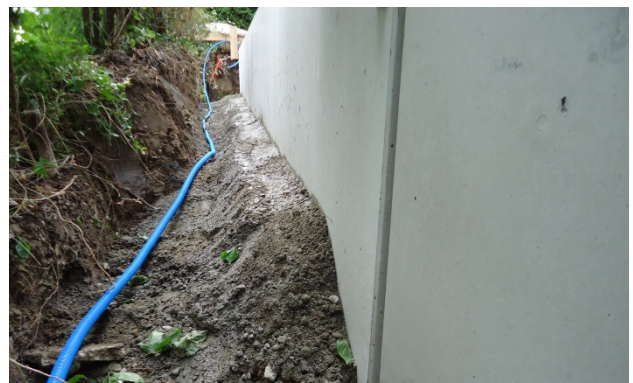
Bild 26: Erstellen der Fundamentnocken
