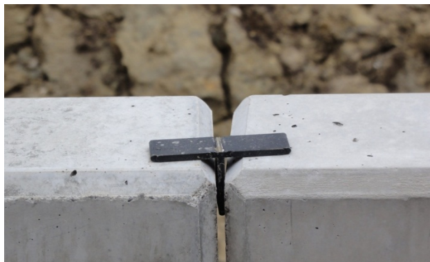
Bild 39: Optimale Fugen nach der Versetzung
