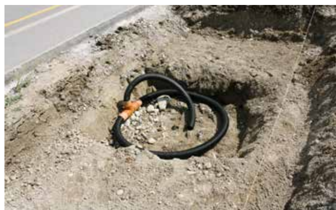
Vorbereitete Sickerrohre in der Baumgrube
