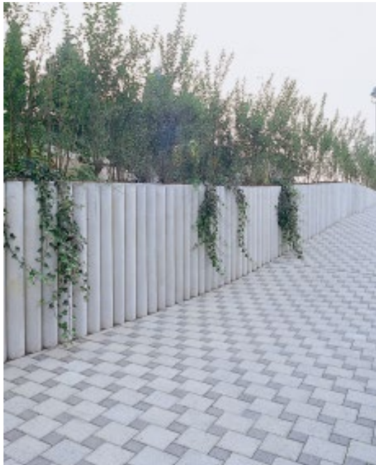
Bild 16: Betonhohlpalisaden als Hangsicherung
