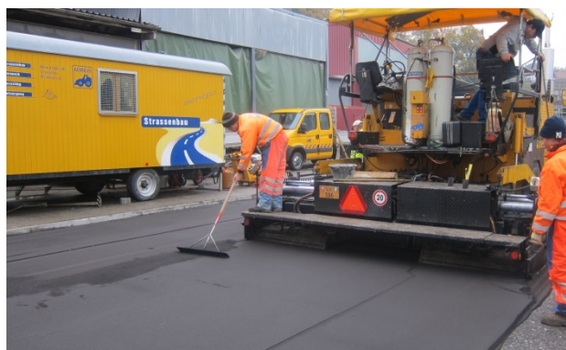
Bild 2: Einbau von ECOPREC®-Bettungsmaterial
