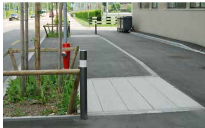
Einbau von Wurzelbrücken seitlich der Baumgrube
