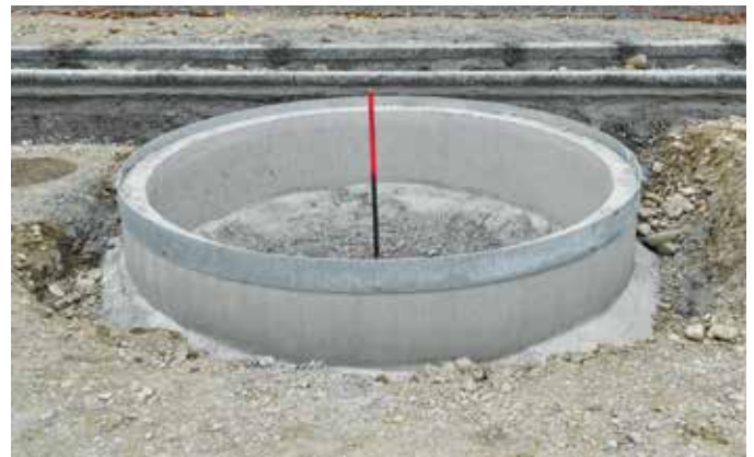
Montierter Stahlleinbaurahmen mit Bolzenanker
