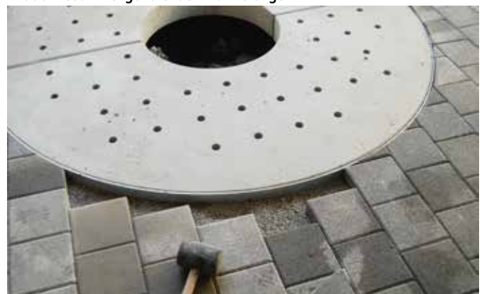
Versetzte TREETUB Betonabdeckung 2-teilig
