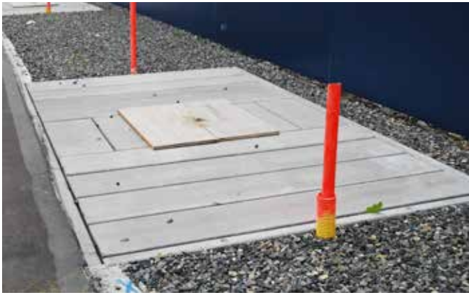
Einbau von Bewässerungs- und Belüftungsleitungen
