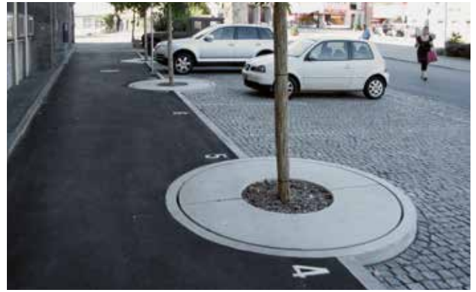
Anlegen von Hochborden
