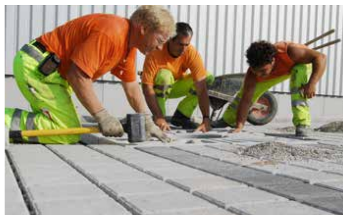
Versetzen der COMO Baumscheiben
