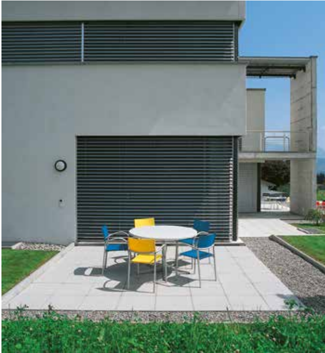
Sitzplatz mit vollkantigen Gehwegplatten
