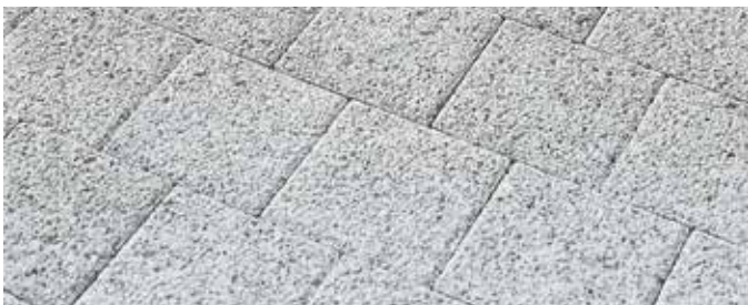
Versickerung durch wasserdurchlässige Pflastersteine (Sickersteine)
