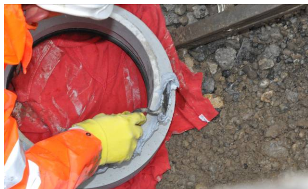
Bild 9: Auftragen der Klebmasse auf den Schaft
