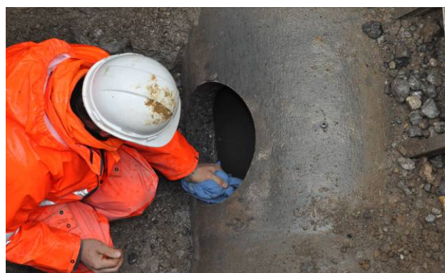
Bild 7: Bohrloch reinigen
