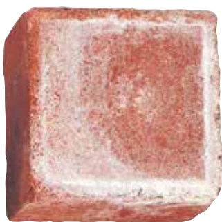
Pflasterstein mit starken Ausblühungen
