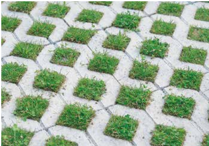
Rasengitterstein mit Versickerung durch eingelassene Kammern
