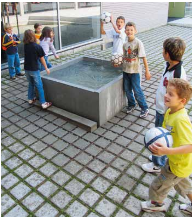
Pausenplatz mit Rasenfugenstein
