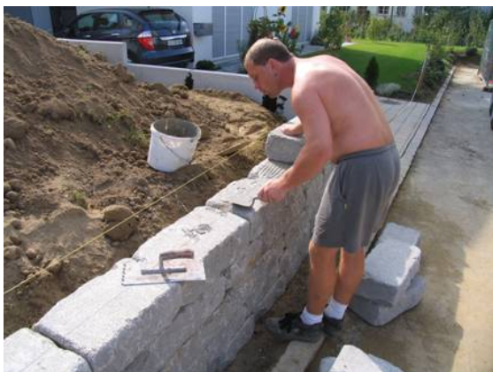
Bild 38: Mörteln der Fugen
