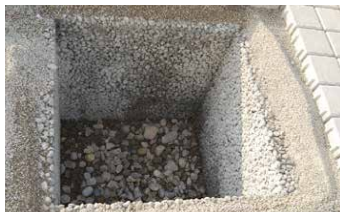
Erstellter Fundamentrahmen
