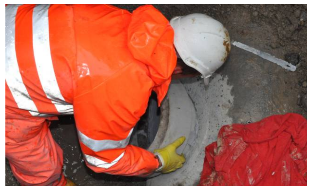
Bild 11: Klebeanschlussstück mit einer Drehbewegung einsetzen
