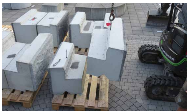
Illustration 21 : douilles de transport M16 montées en usine
