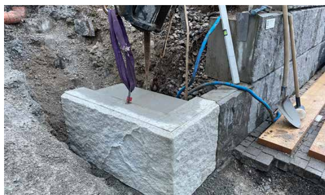
Illustration 22 : briques initiales avec semelle filante sans mortier-colle
