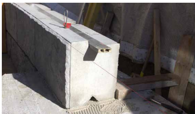
Illustration 23 : semelle filante avec couche mince de mortier-colle
