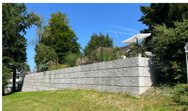
Illustration 26 : garde-corps sur le couronnement d'un mur
