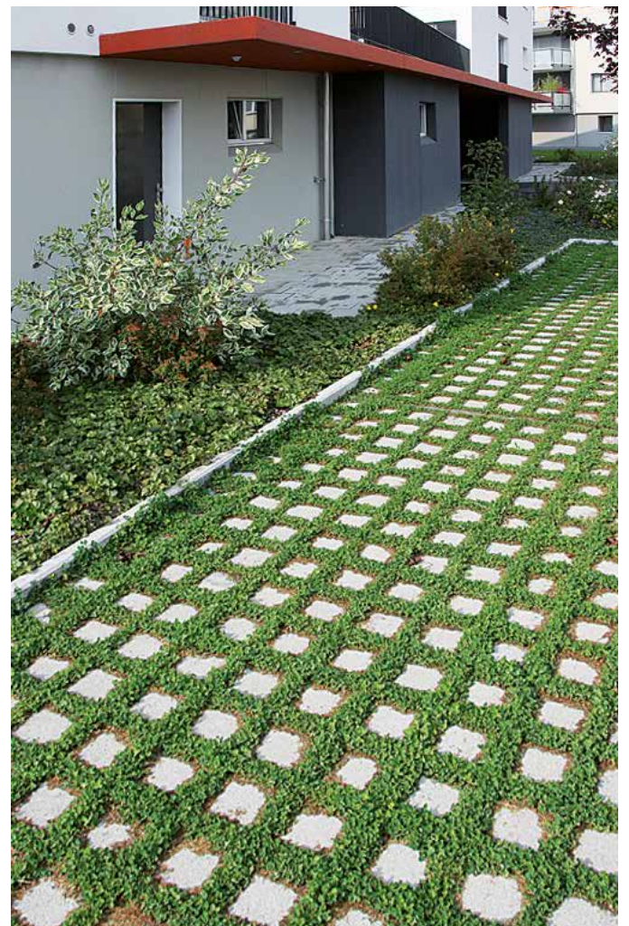
Parkfläche mit CLASSIC® Rasenfuge
