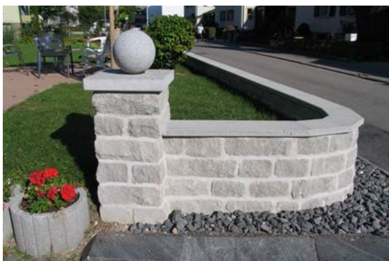
Bild 44: Versetzte SANTURO® Abdeckplatten in Segmente geschnitten
