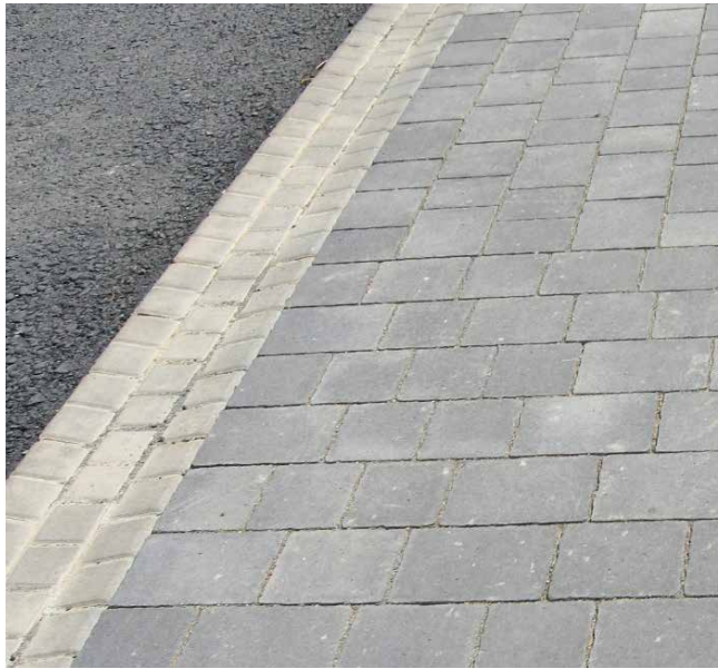
Formation possible de cunettes avec des cunettes en pavés.
