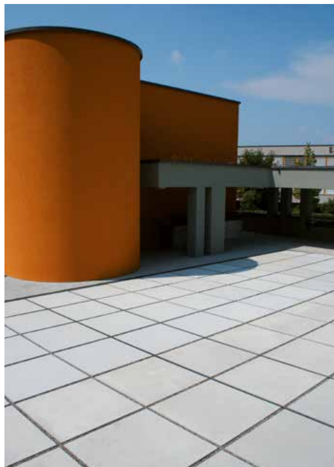
Optische Raumerweiterung mit grossflächigen Platten
