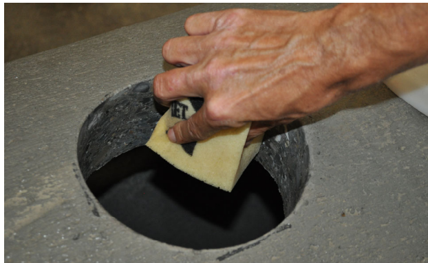
Bild 8: Bohrlochwandung mit Wasser befeuchten
