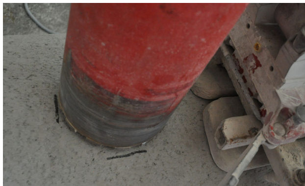
Bild 6: Korrekt montiertes Kernbohrgerät
