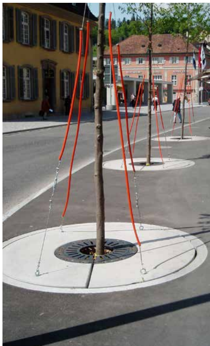
COPAL CUPOLA Baumwurzelraumschutz mit Gusseinsatz
