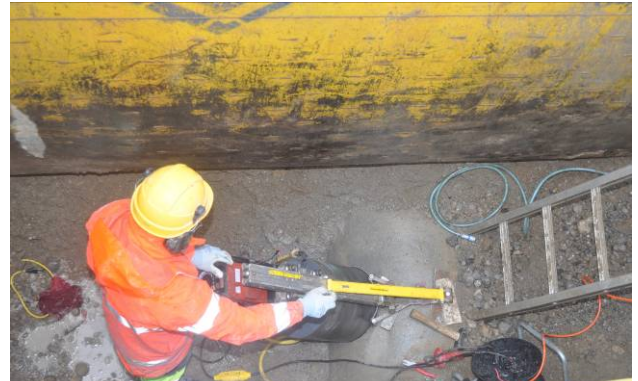
Bild 6: Korrekt montiertes Kernbohrgerät
