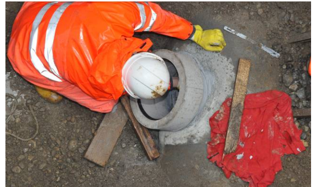
Bild 12: Innenkante von Hand modellieren und Reste entfernen
