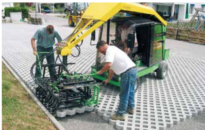
Maschinelles Verlegen mit OPTIMAS-Verlegemaschine
