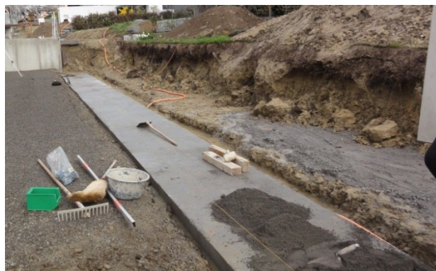
Bild 27: Erstelltes Streifenfundament
