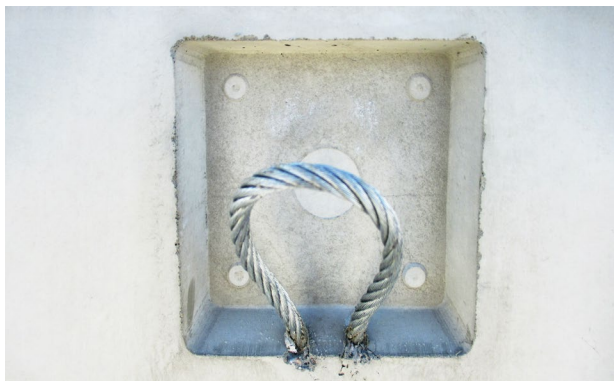
Bild 24: Werkseitig eingebaute Versetzschlaufen
