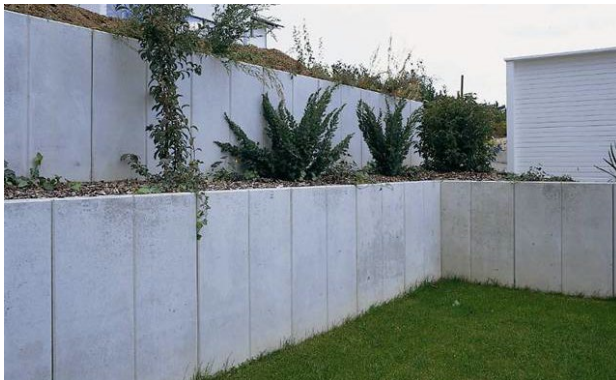
Bild 1: COMOFORTE® Winkelplatten als Böschungssicherung
