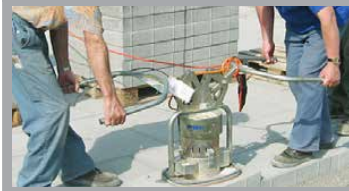
SPEEDY APPAREIL DE POSE PAR LE VIDE 230 V
