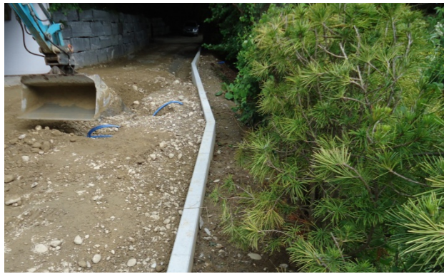
Bild 41: Lagenweises Einbringen von geeignetem Hinterfüllmaterial
