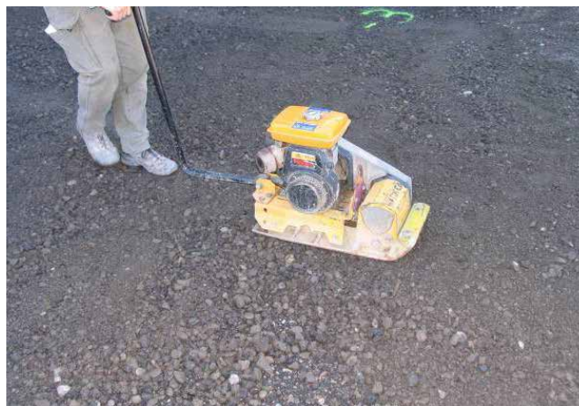
Compactage de la couche de fondation
