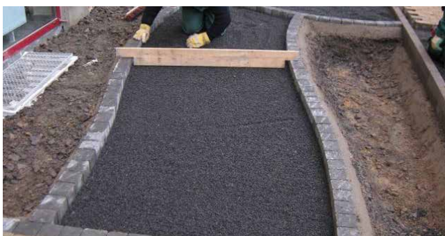
Bordures latérales en pavés bétonnés
