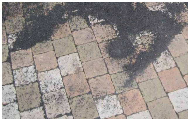
Remplissage des joints
