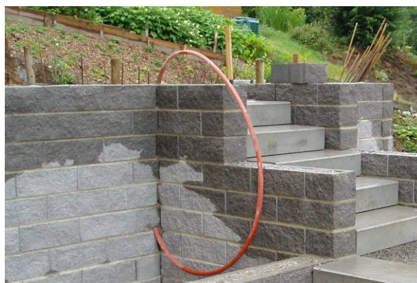
Bild 40: Einlegen der Leerrohre
