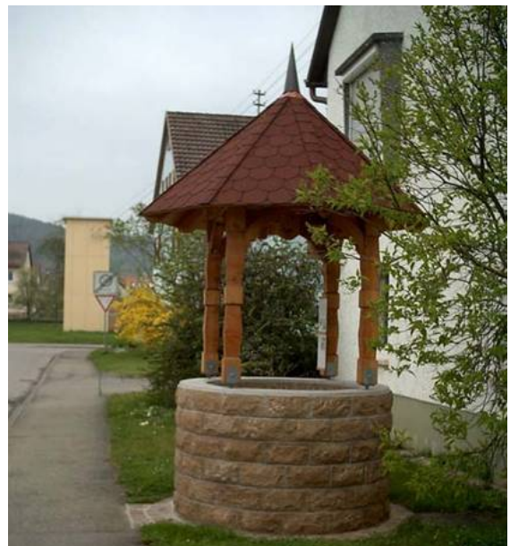
Bild 32 Brunnenbau mit SANTURO® Keilmauersteinen
