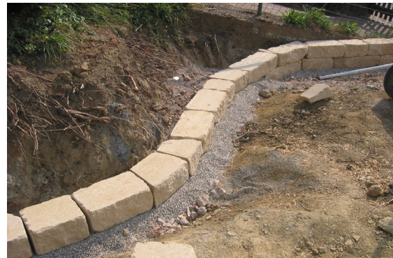
Bild 24: Versetzte erste Steinreihe in Kiesfundament
