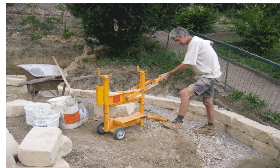
Bild 35: Arbeiten mit Steinspalter
