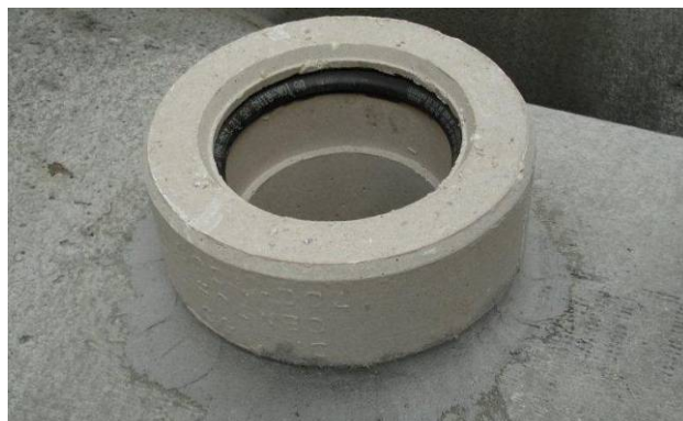
Bild 1: CENTUB® Klebeanschlussstück 90° eingebaut
