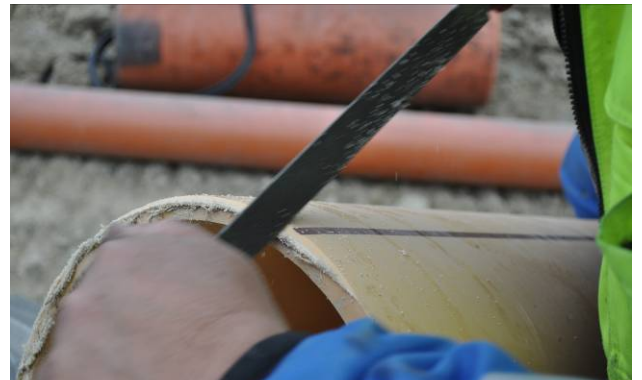
Bild 14: Anfasen des Kunststoffrohres, reinigen und einschmieren
