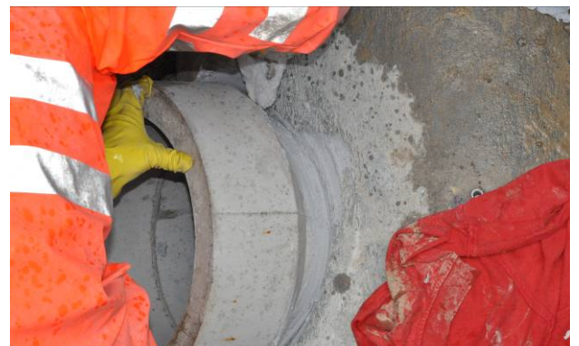
Bild 13: Bilden der äusseren Kehlkannte
