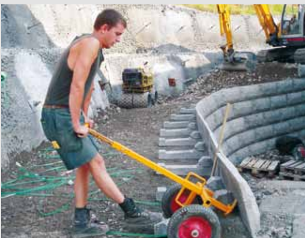
Einfaches Versetzen mit Handwagen
