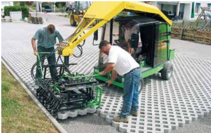
Maschinelles Verlegen mit OPTIMAS-Verlegemaschine
