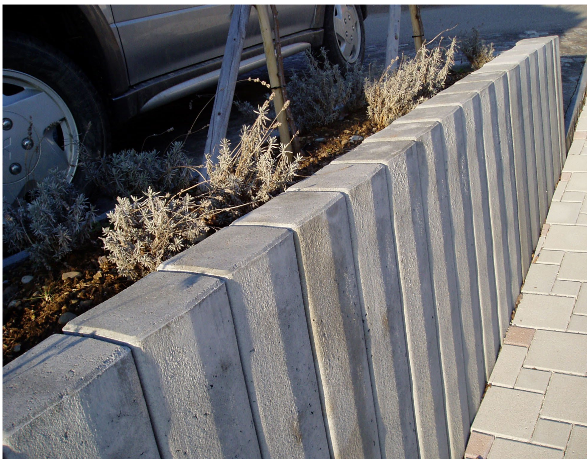
Bild 1: Betonhohlpalisade rechteckig
